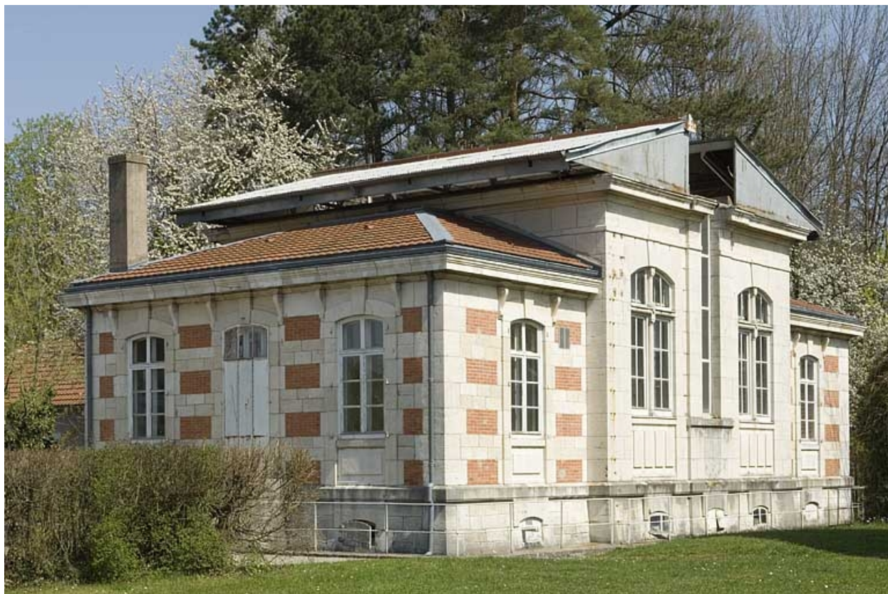
Pavillon de la méridienne, toiture ouverte.
