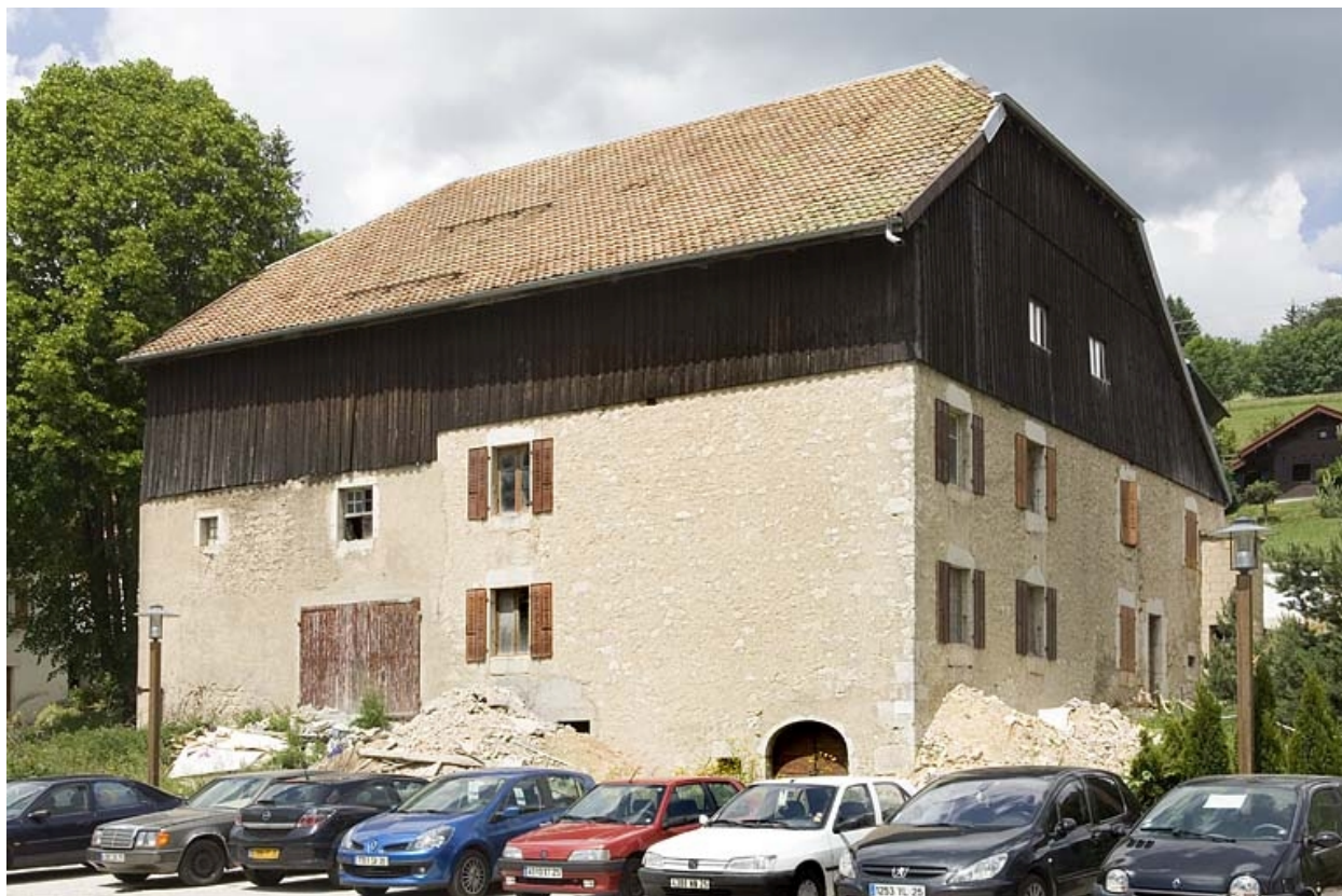
Façades postérieure et latérale gauche.
