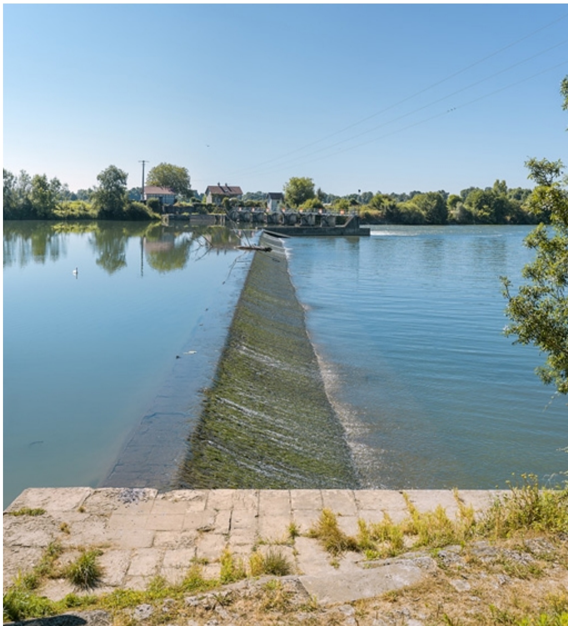
Le déversoir du barrage.
