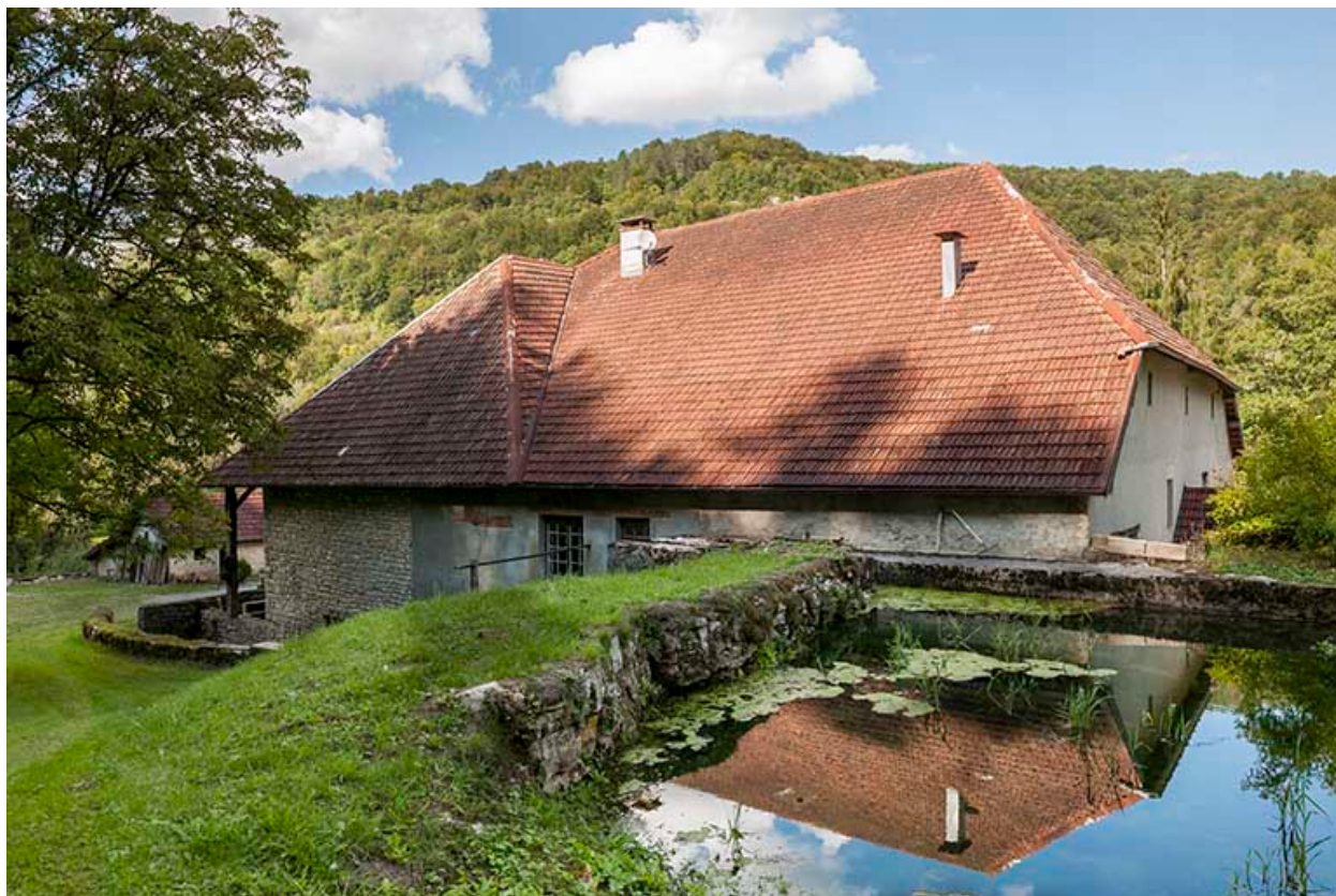
Vue plongeante depuis le sud-est.
