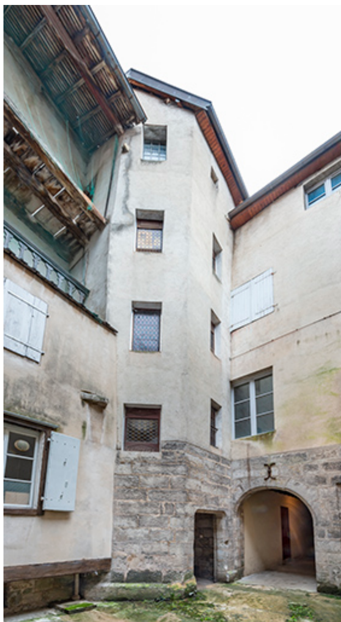
Tour d'escalier polygonale, depuis la cour.
