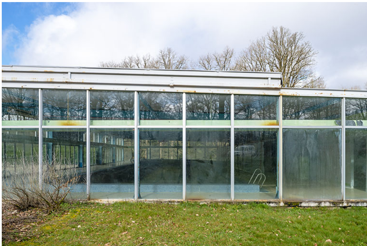
Détail de la façade sud-est, à l'avant du bassin.
