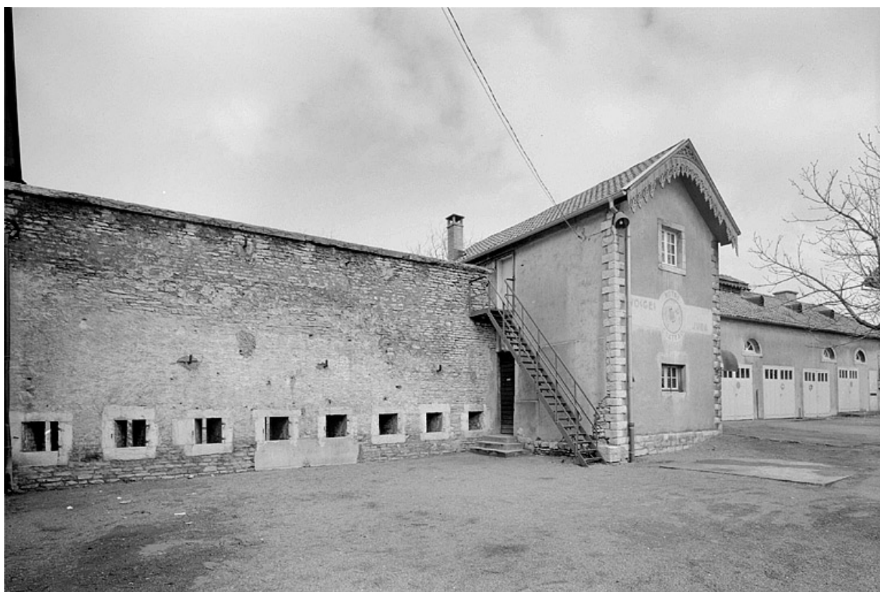
Enceinte. Partie vue de la basse-cour (p).
