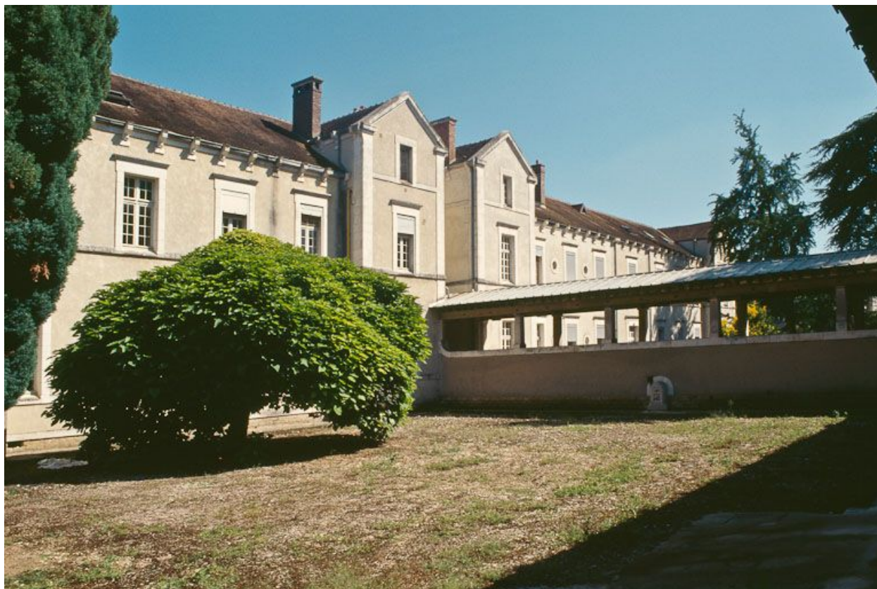
Quartier des femmes, bâtiments postérieurs, façades ouest.
