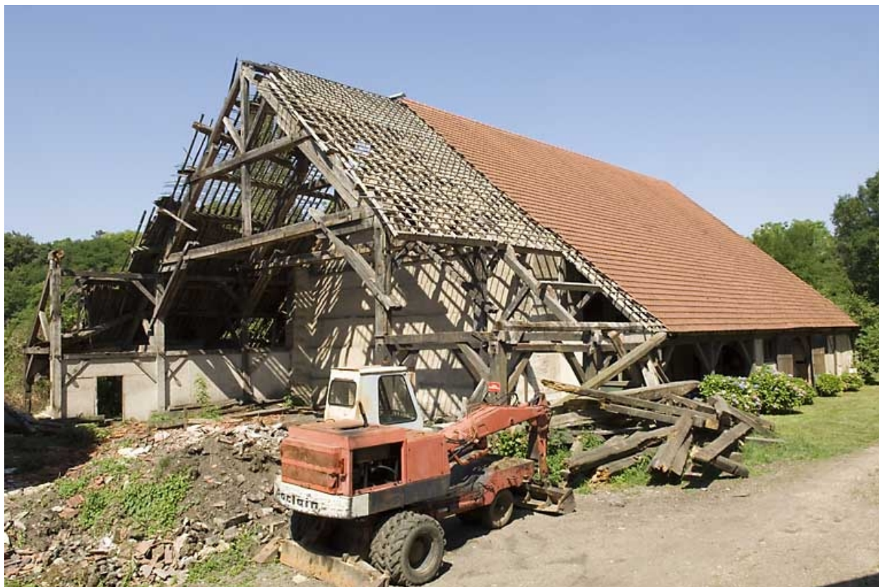
La halle à charbon vue depuis l'est.
