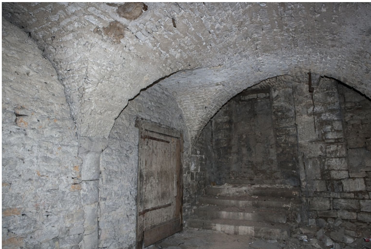
Logis principal, sous-sol : cave C.
