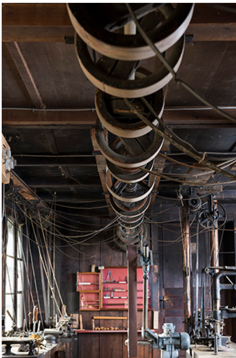
Ligne de transmission principale, entre les deux grands établis.
