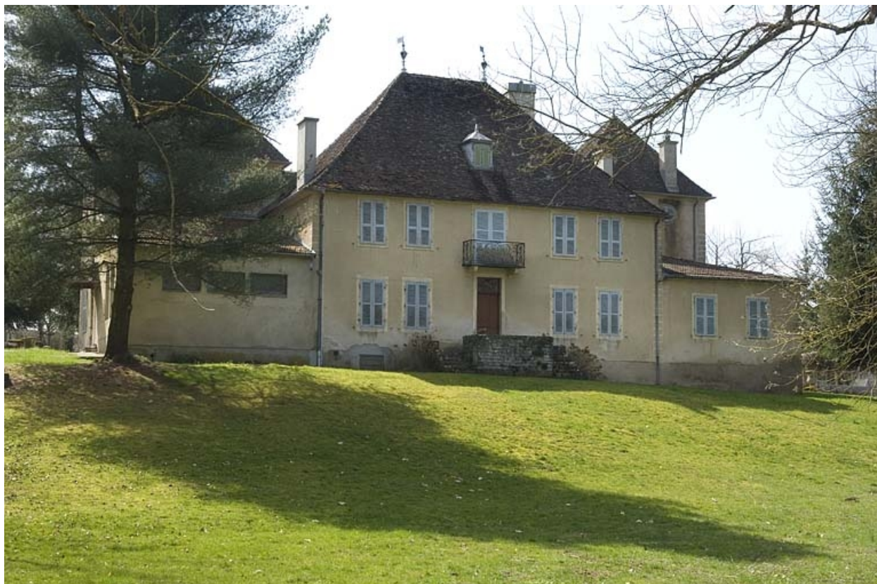
Façade postérieure du logement patronal.
