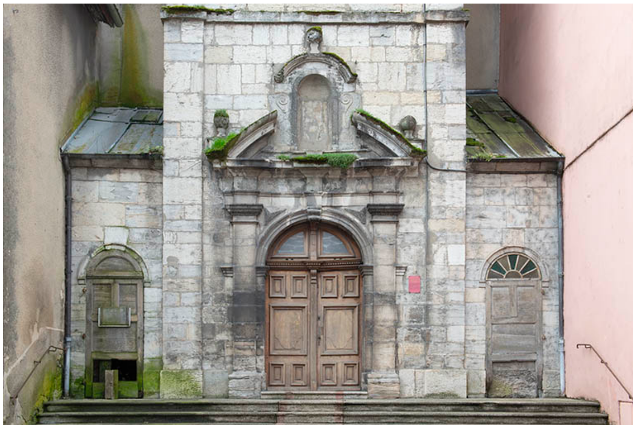
Partie basse de la façade nord.
