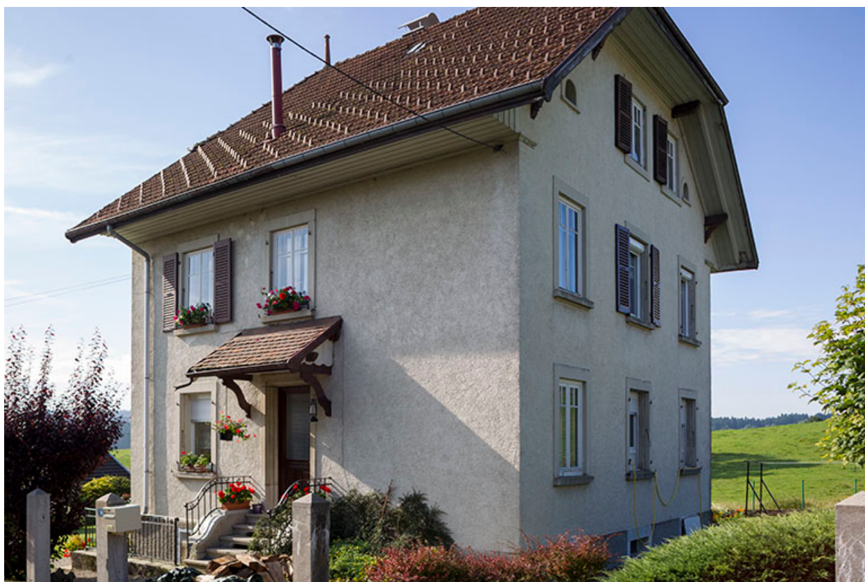
Façades antérieure et latérale droite.
