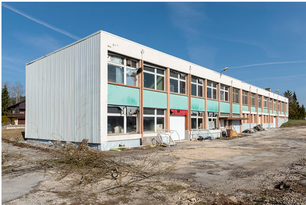
Façades postérieure et latérale droite.
