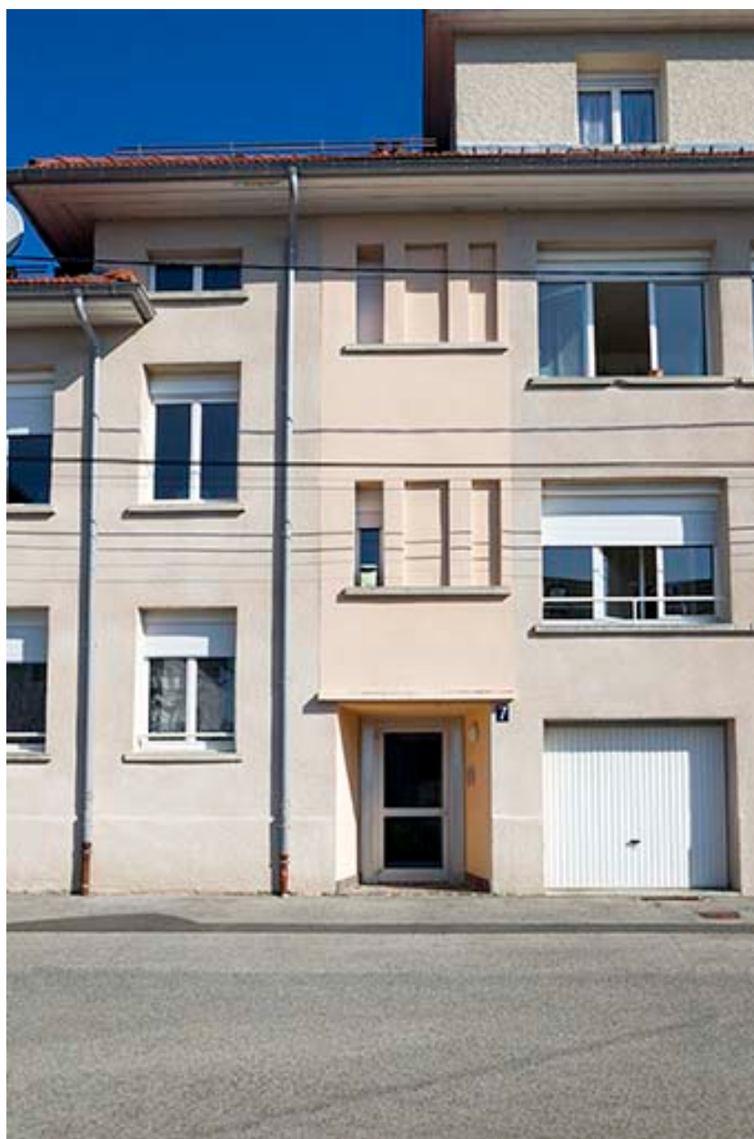
Façade antérieure : entrée.
