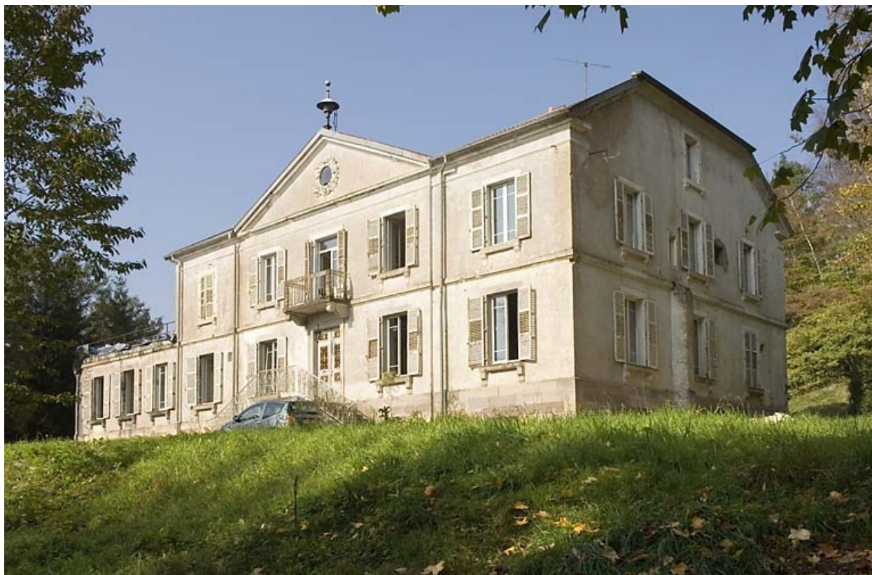
Château dit des Houillères.
