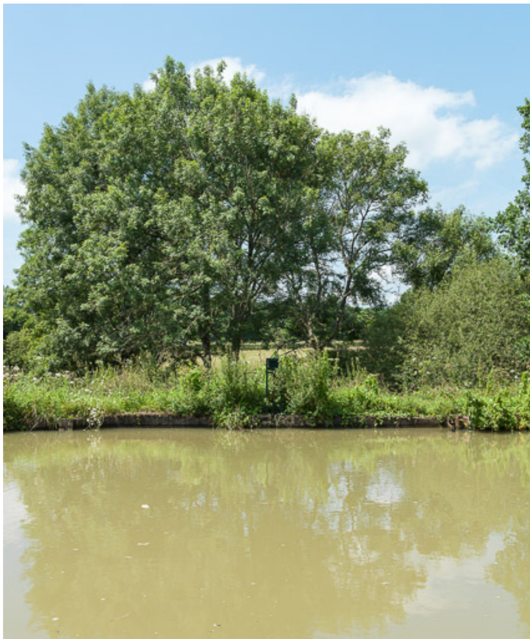
Vue du déversoir.
