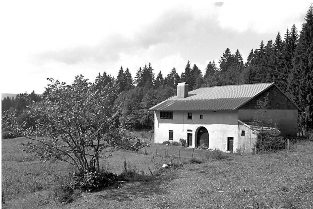
Façade sud-est, vue éloignée.
