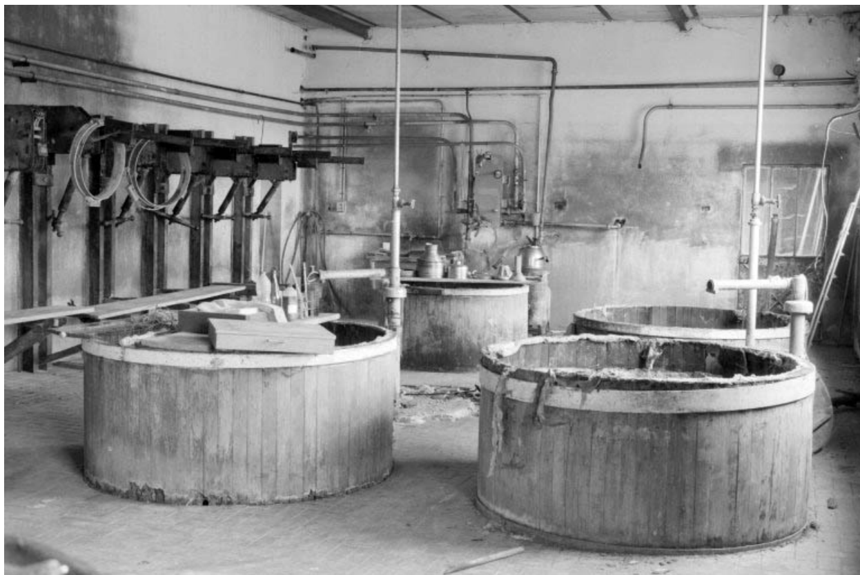
Intérieur de l'atelier de fabrication.
