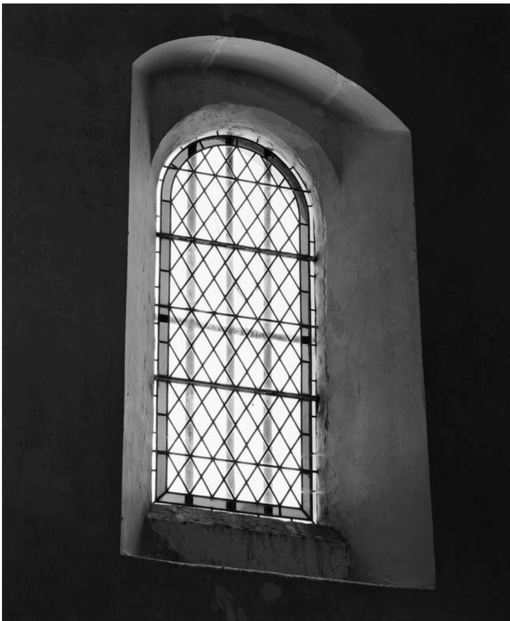
Deuxième fenêtre gauche de la nef.
