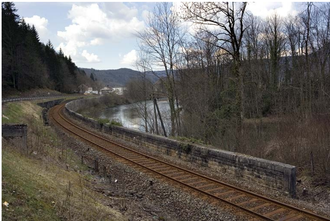
Vue d'ensemble, depuis le côté Andelot-en-Montagne.
