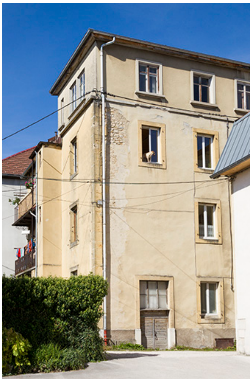
Façades latérale gauche et postérieure.
