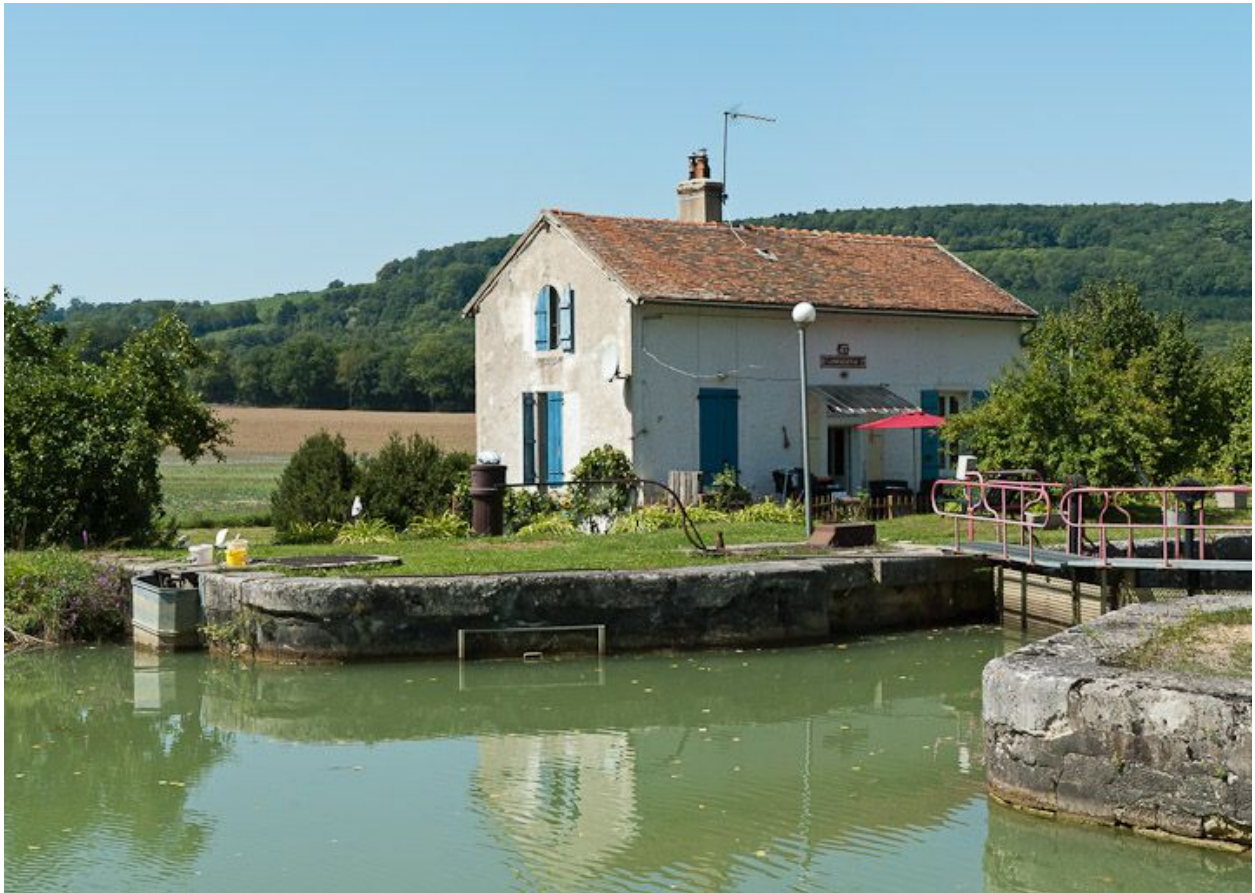
Vue du site d'écluse depuis l'amont.
