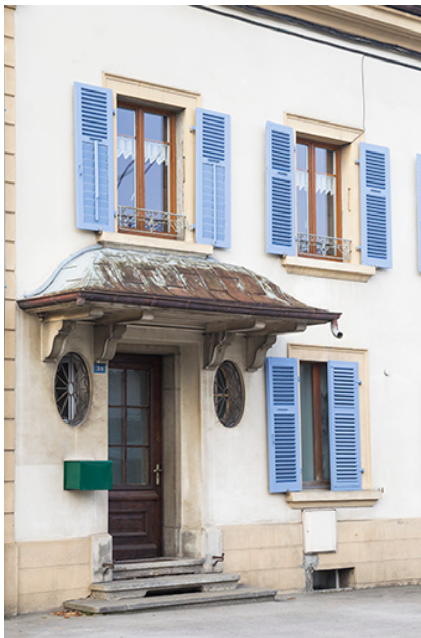
Façade antérieure : entrée du logement patronal.
