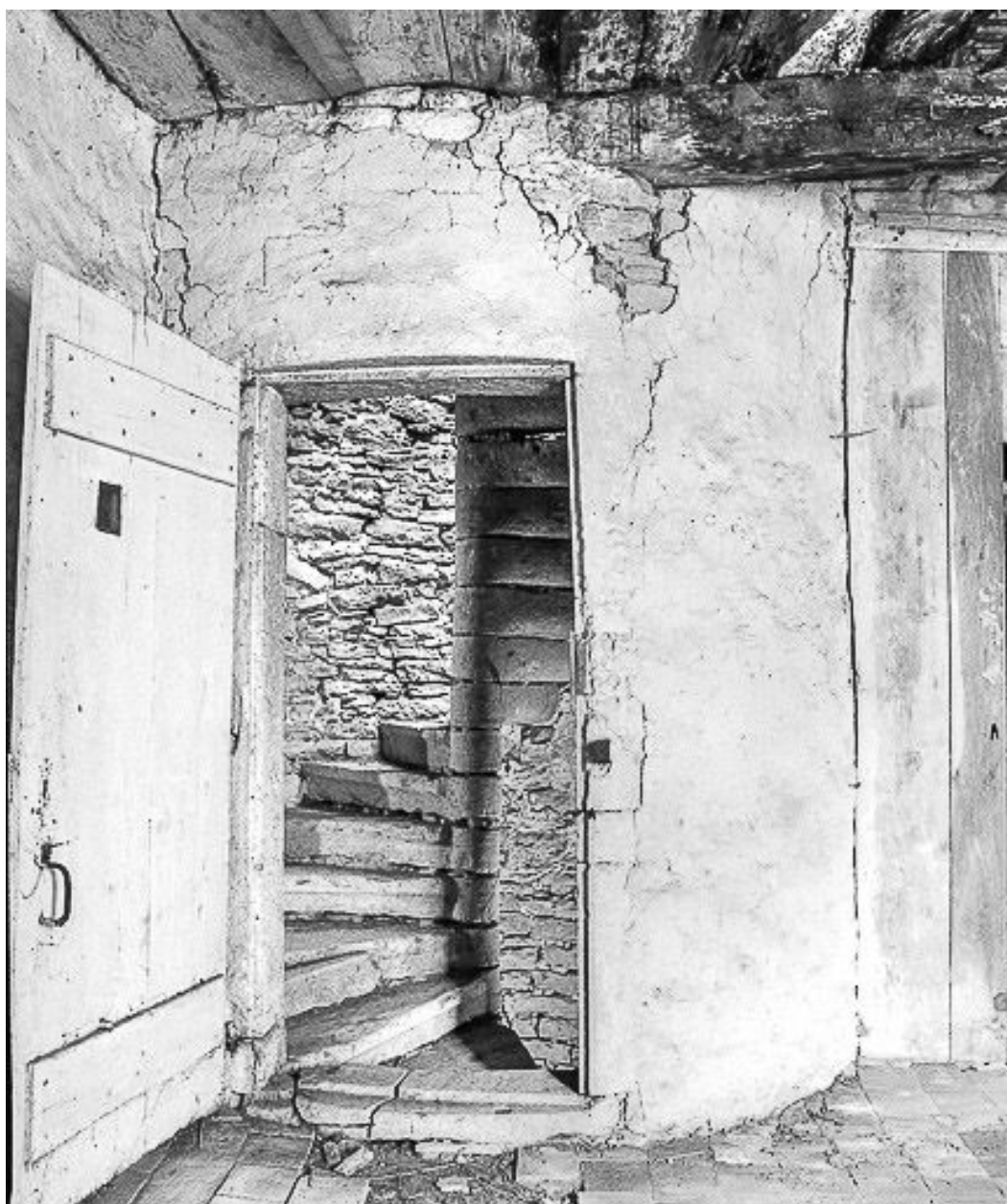
Tourelle d'escalier au niveau du 1er étage.
