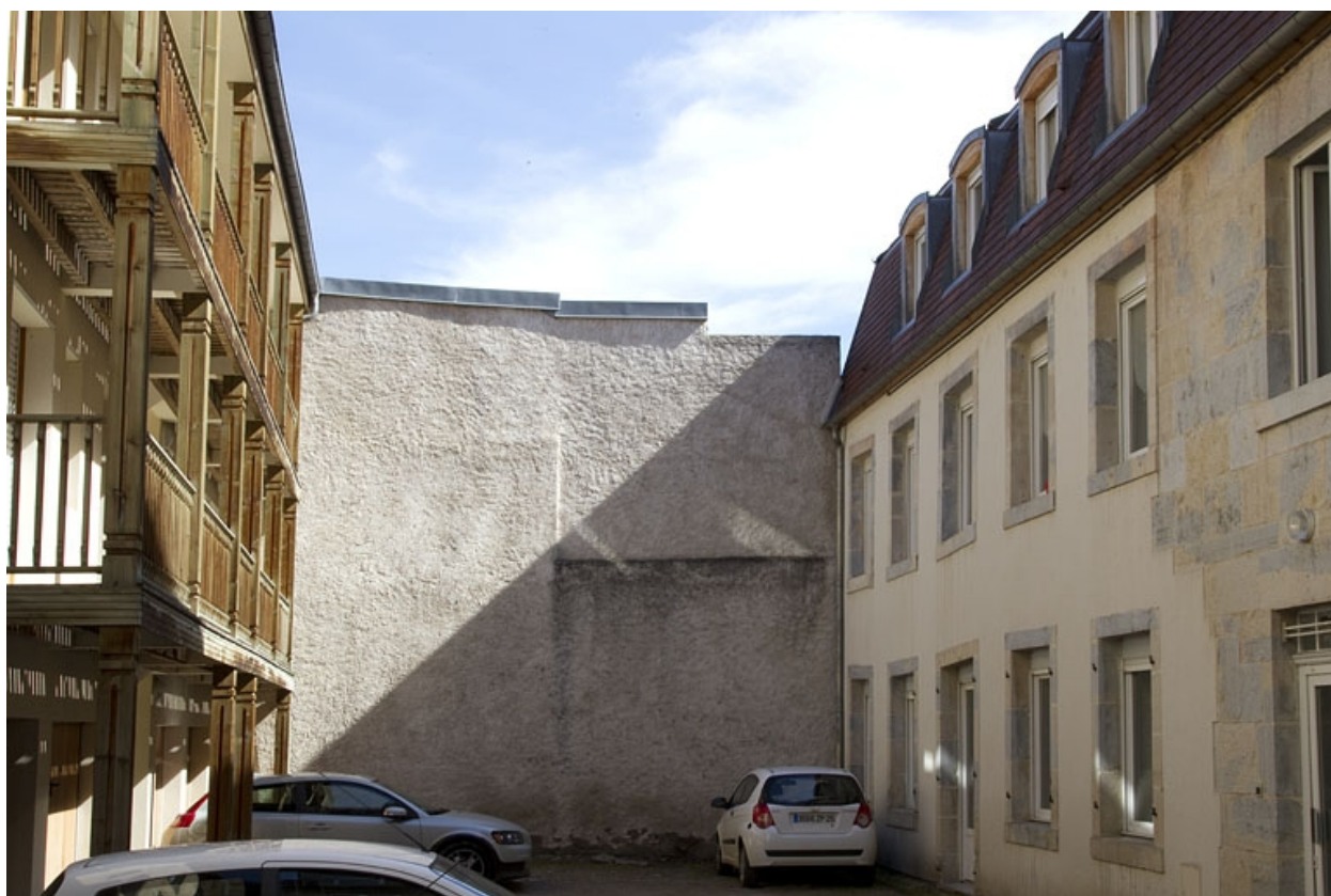
Vue d'ensemble de la deuxième cour.
