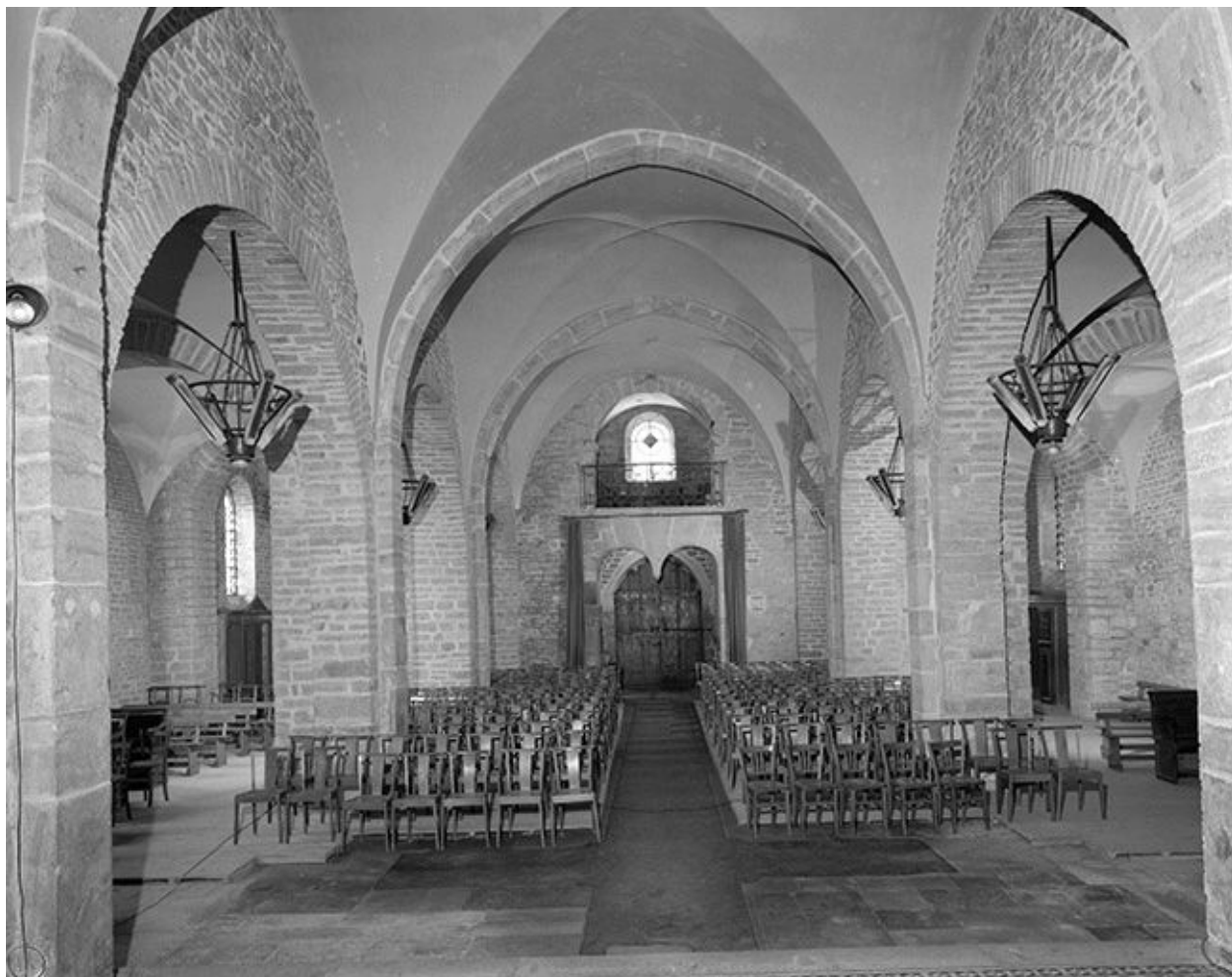
Nef vue depuis le chœur.
