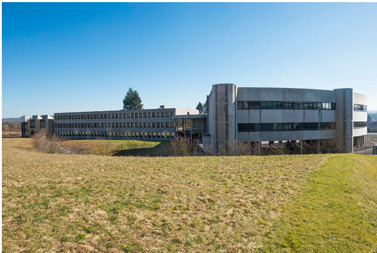
Vue d'ensemble des façades ouest.
