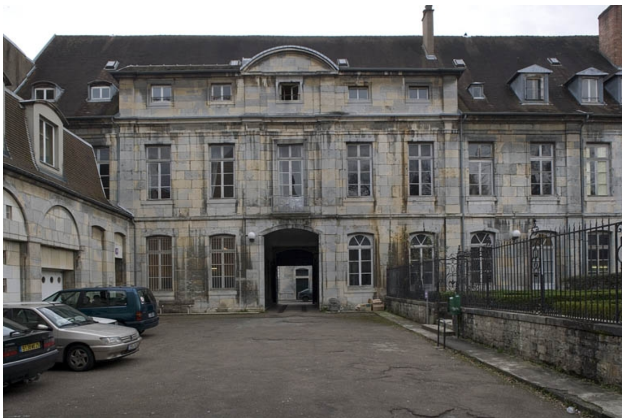
Vue de la façade sur cour.
