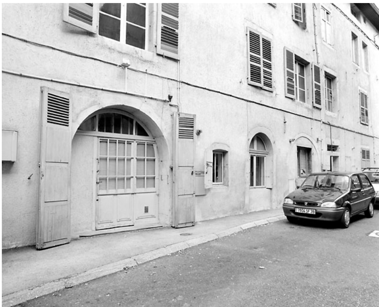
Elévation postérieure : baies du rez-de-chaussée.
