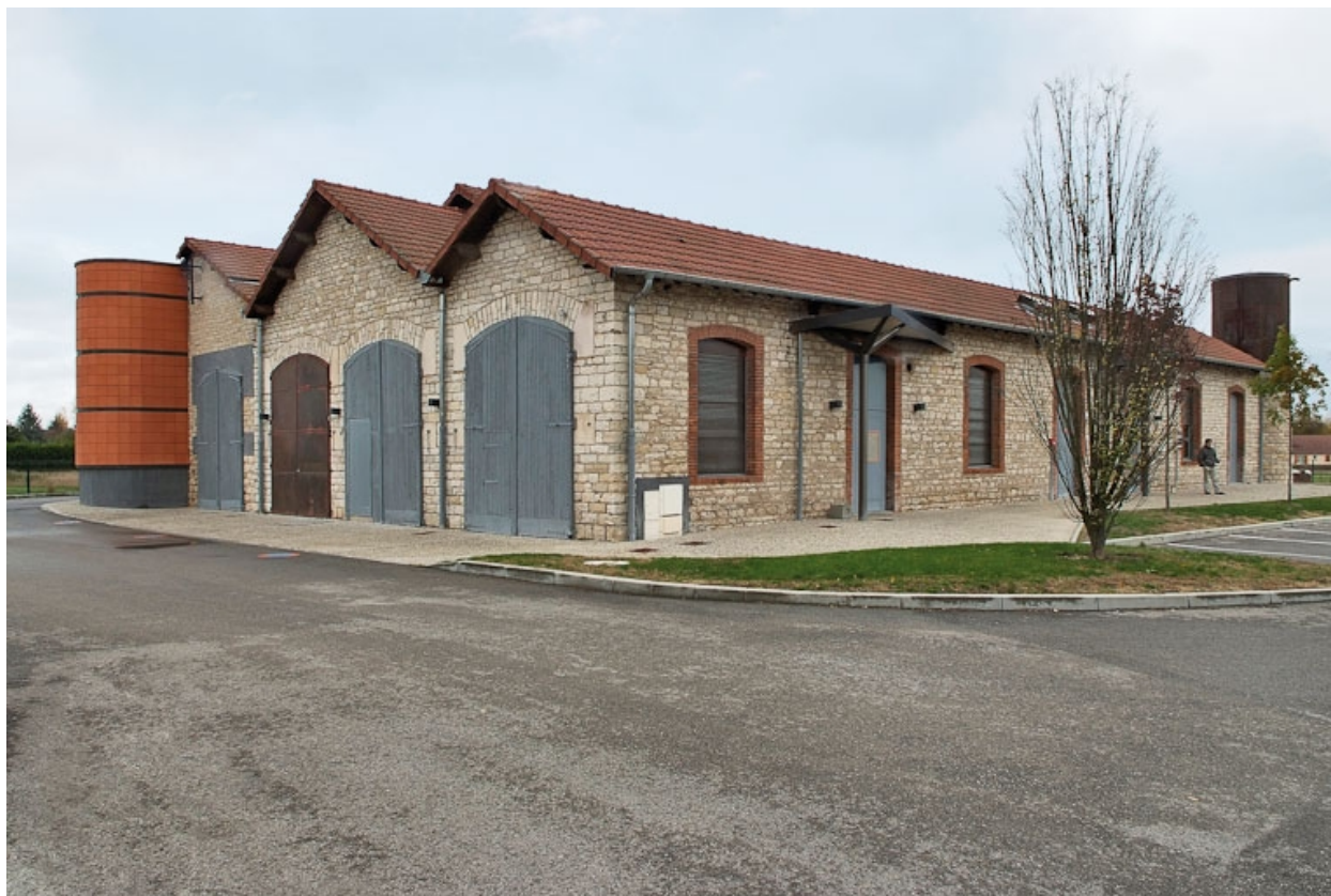
Vue d'ensemble du bâtiment.
