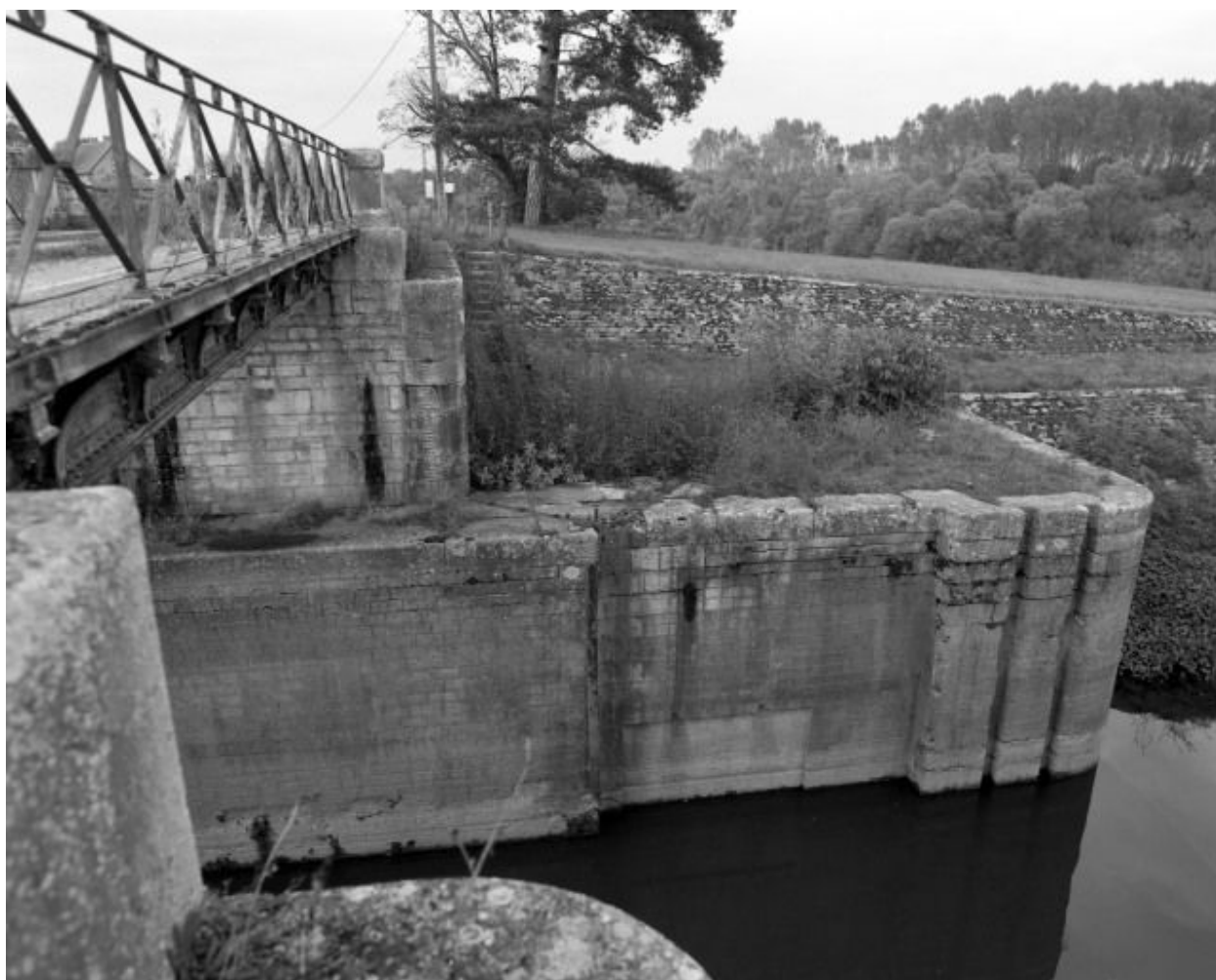
L'entrée est de l'écluse en 2001, détail.
