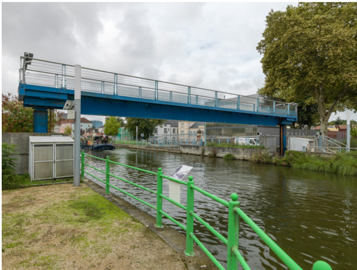
Passerelle remontée après le passage d'un bateau.
