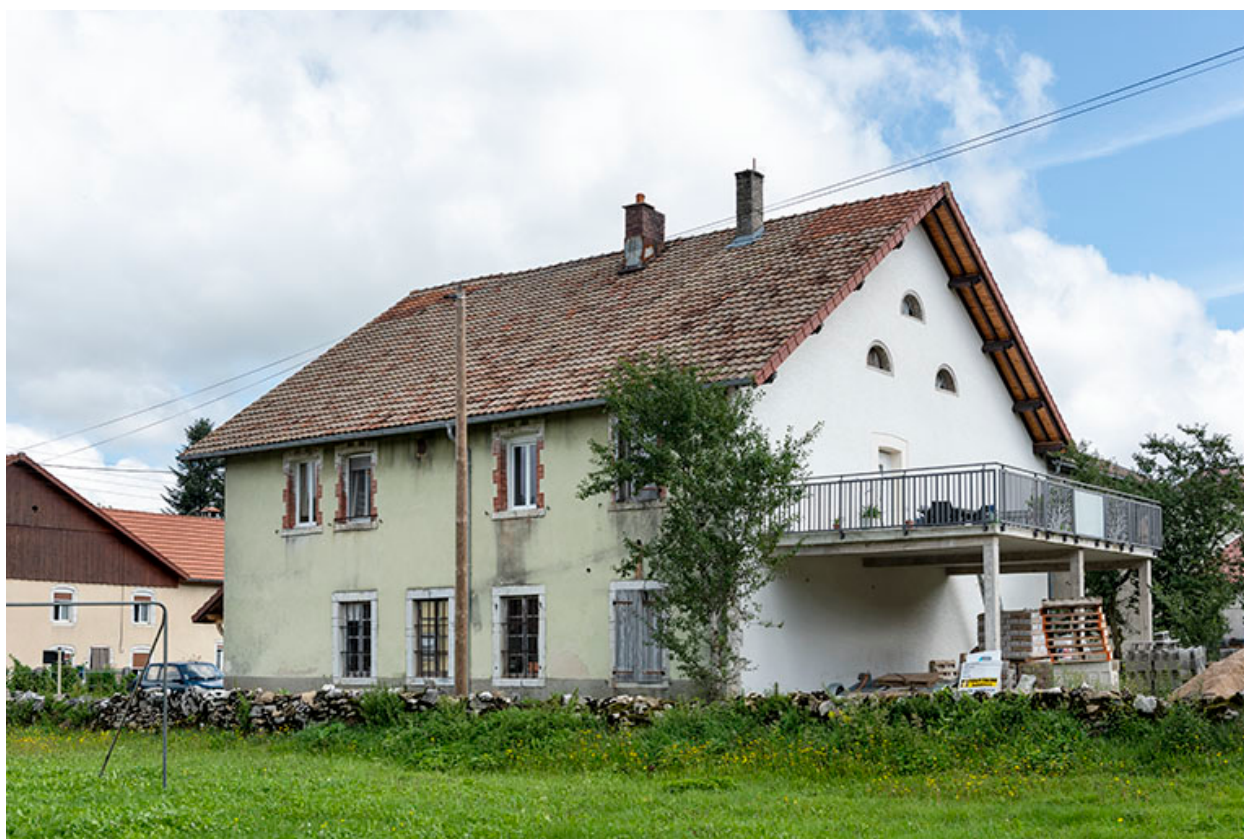
Façades postérieure et latérale droite.
