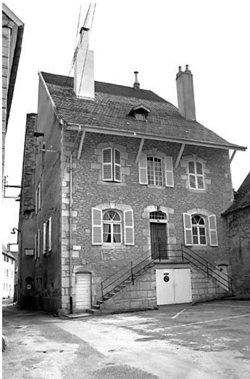
Maison située 4 rue de la Froidière.
