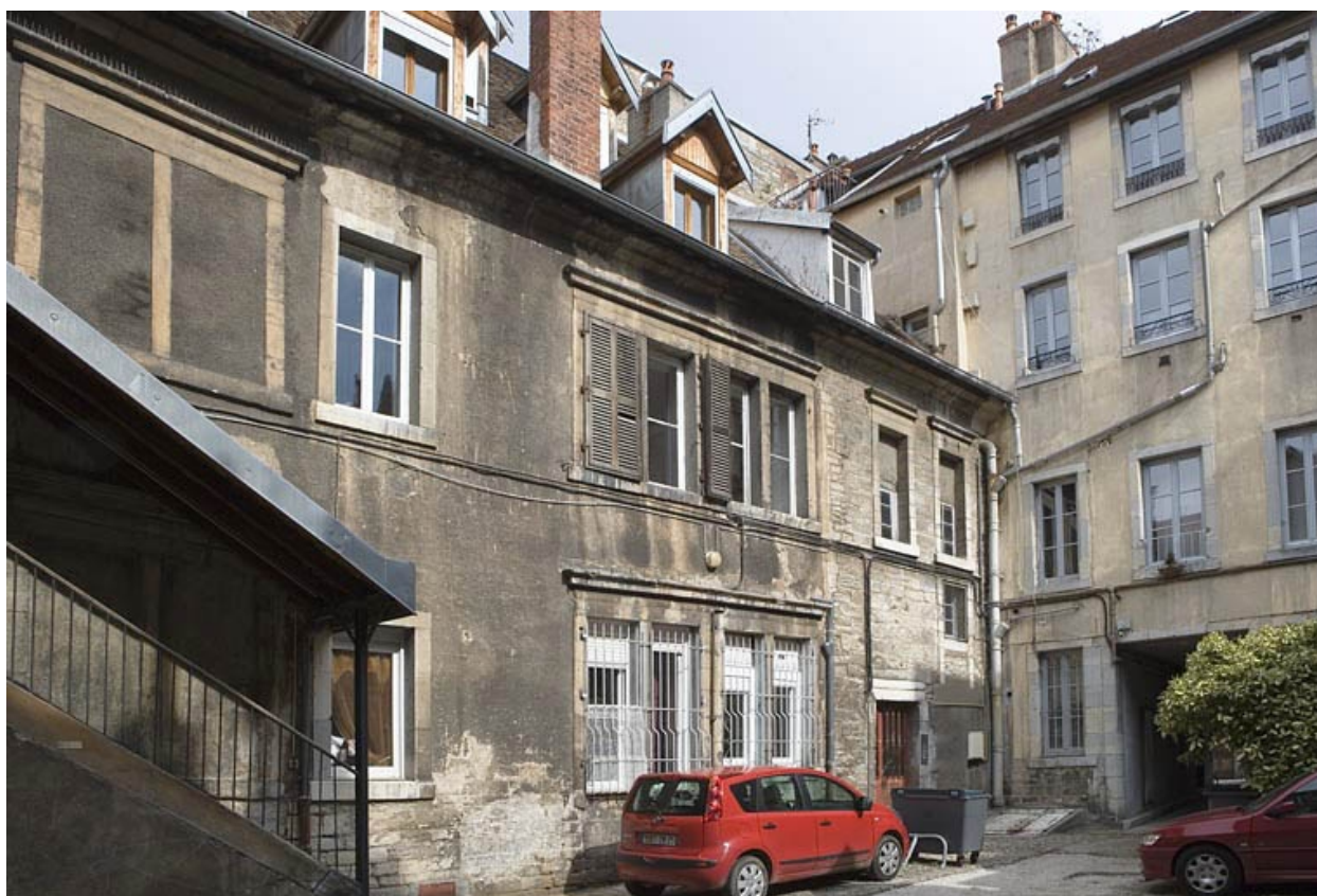
Vue d'ensemble de l'aile sur cour.
