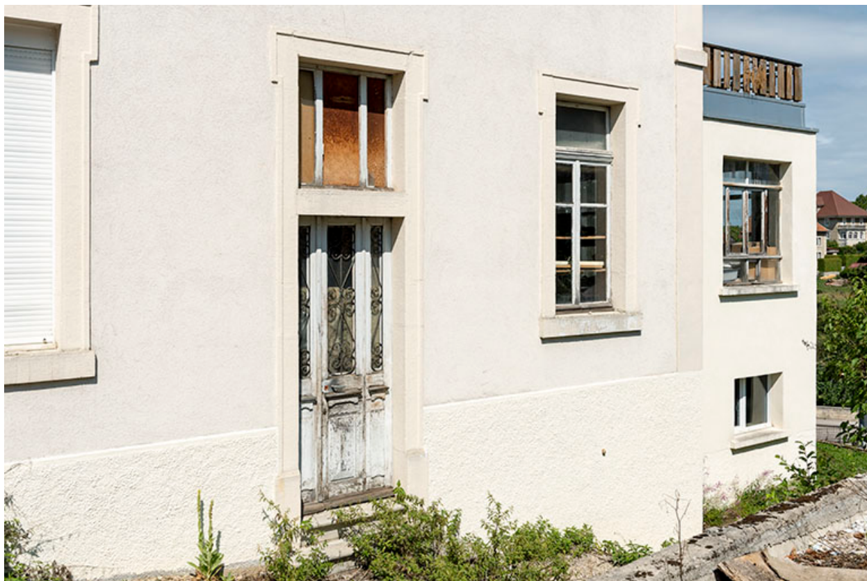
Façade latérale droite : baies du rez-de-chaussée.
