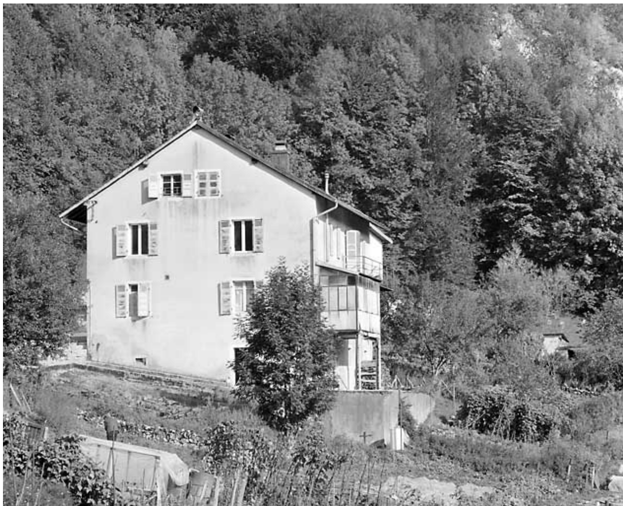
Façades latérale droite et postérieure.
