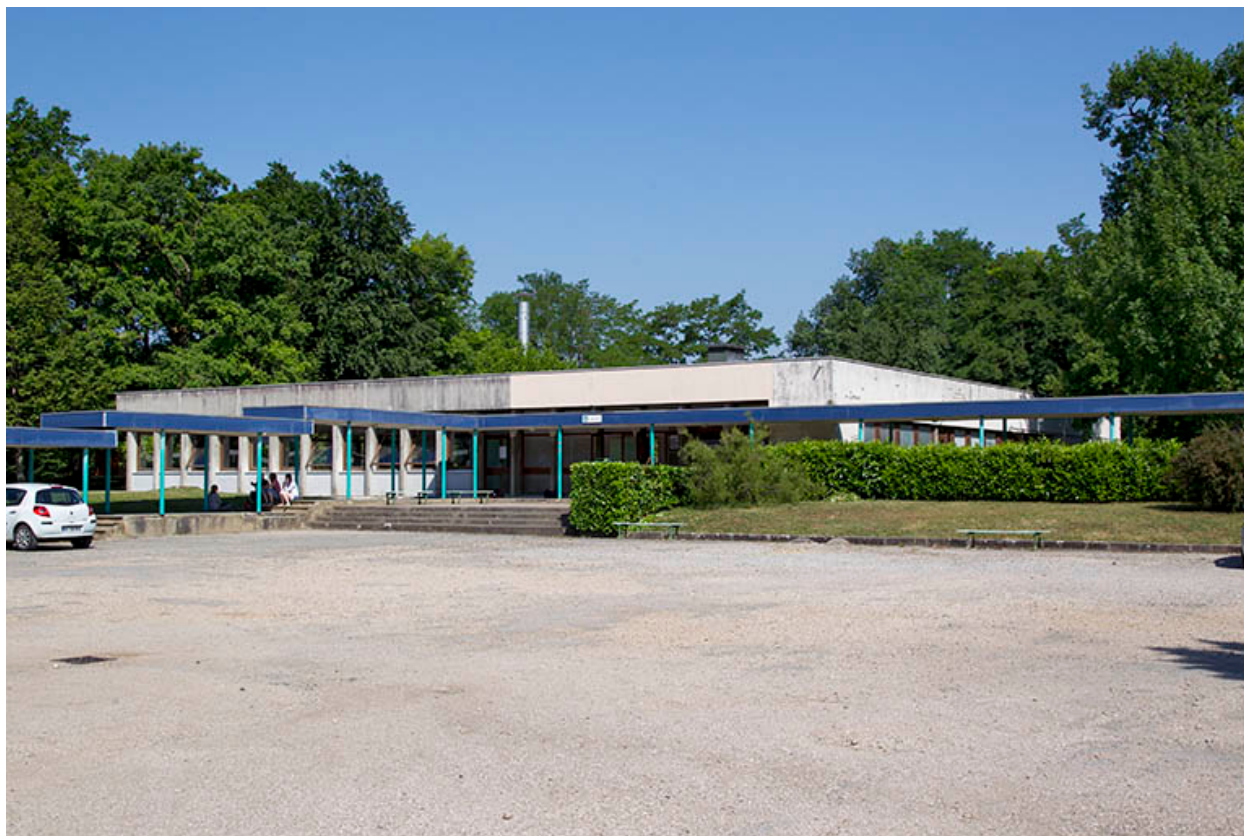
Façade sud de la cantine.
