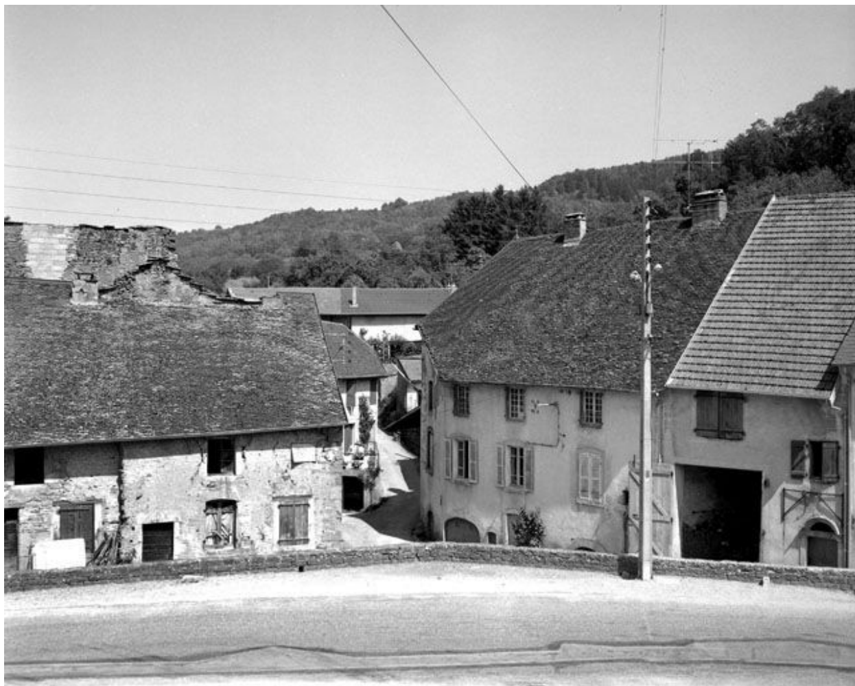
Ferme de vigneron située rue du Château.
