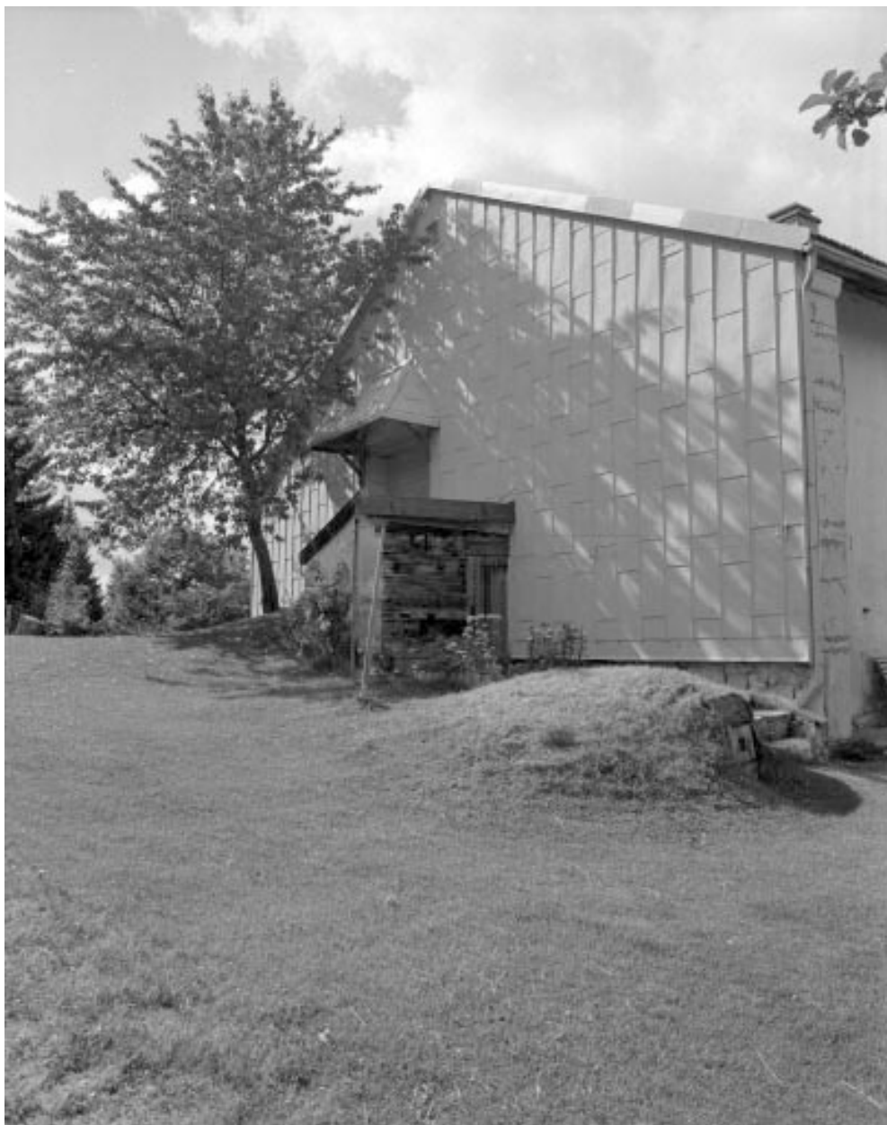
Face gauche recouverte d'un essentage de zinc.
