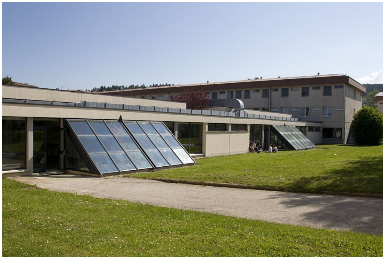
Bâtiment de la restauration : face sud.
