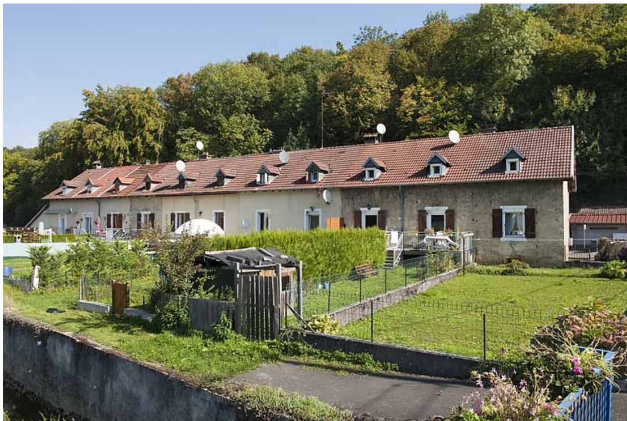
Logement nord (caserne A) depuis l'ouest.
