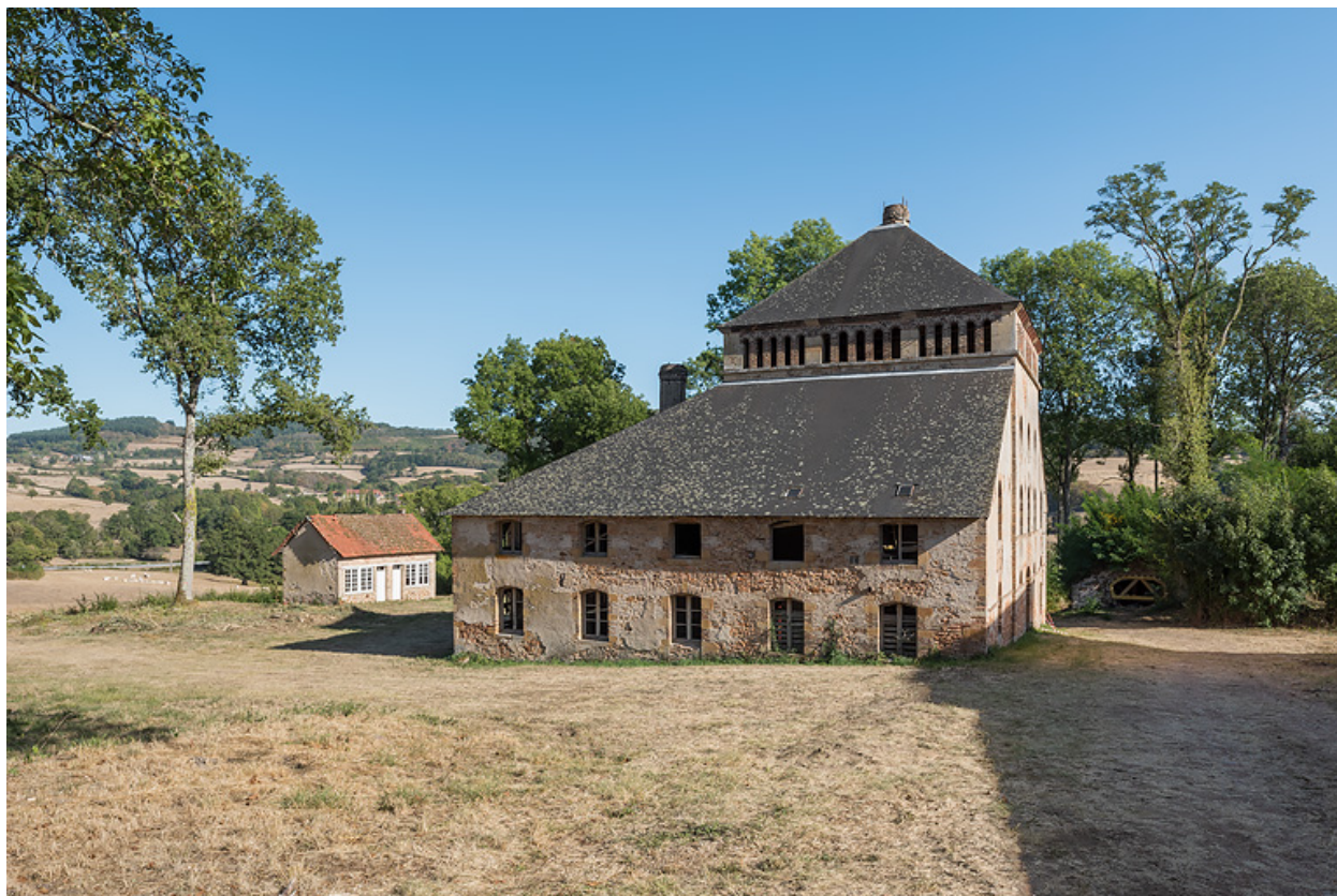
Vue depuis le nord-ouest, état actuel.
