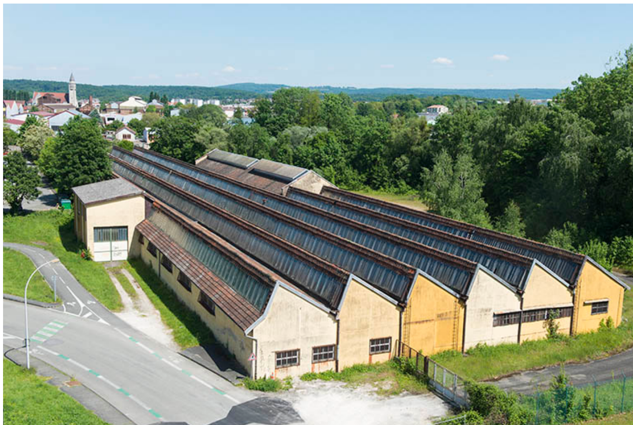
Vue plongeante sur l'ancien atelier de tréfilerie.
