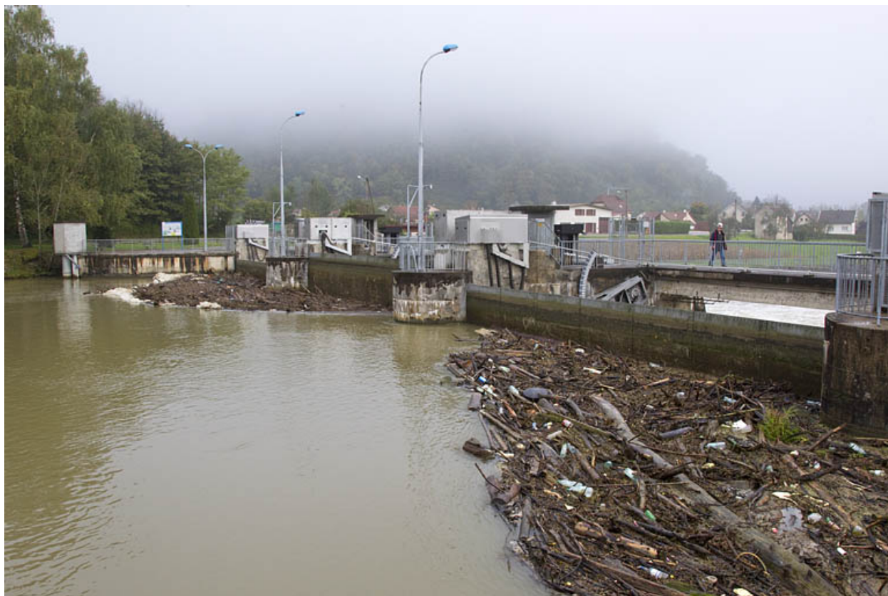
Retenue d'eau en amont du barrage.
