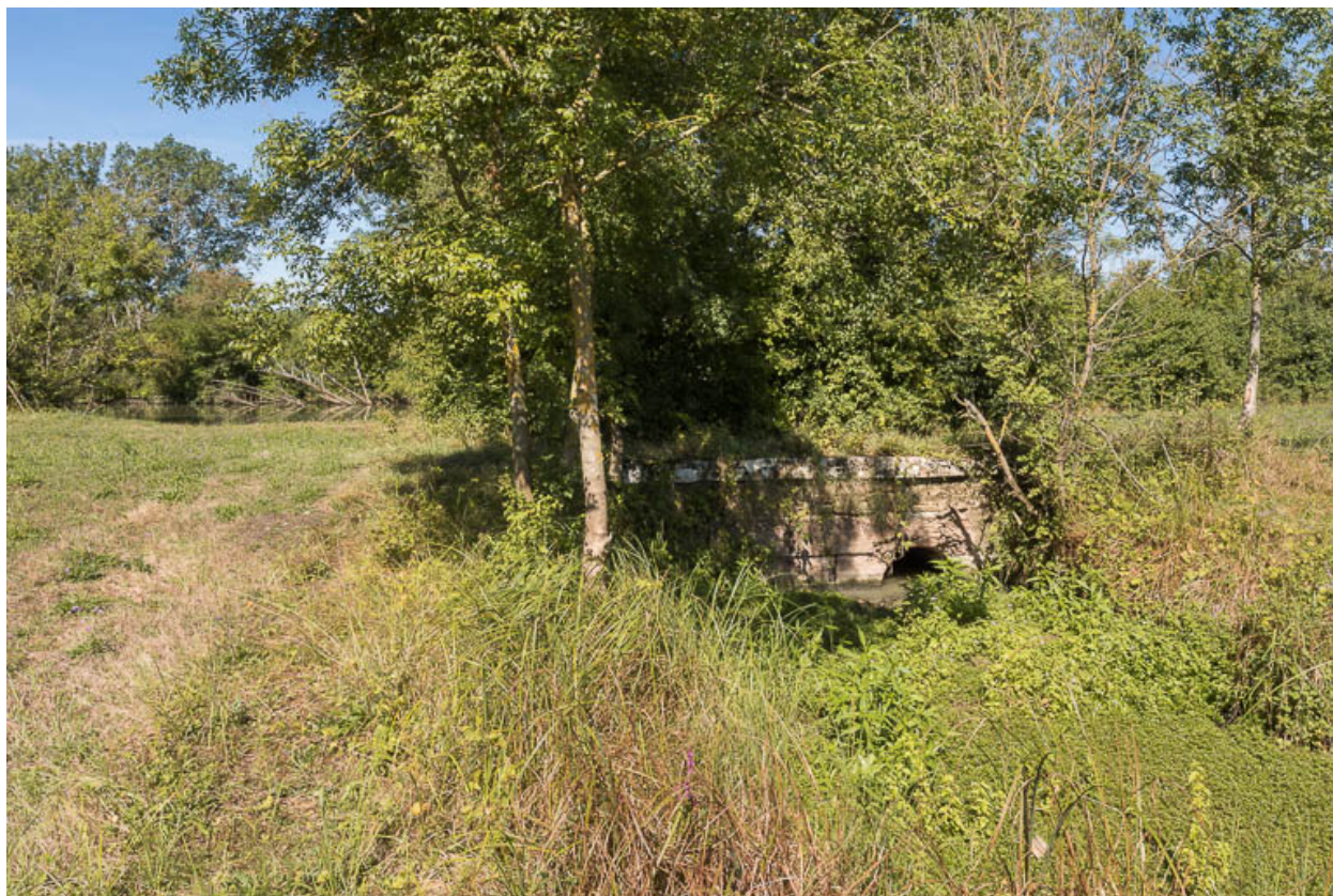
Vue du ponceau.
