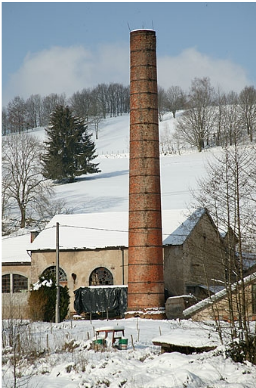
Salle des machines et sa cheminée.
