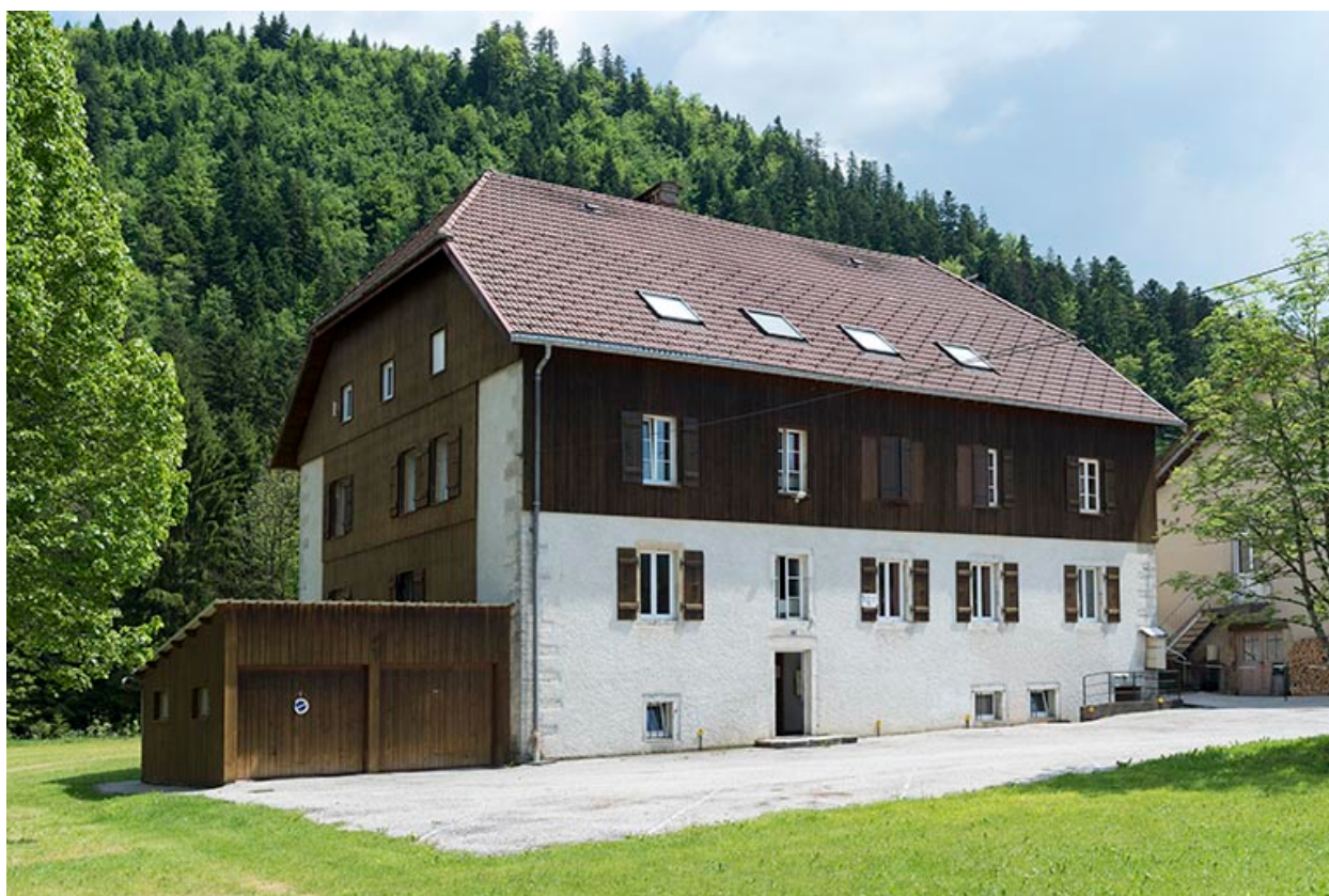
Chaudronnerie : façades antérieure et latérale gauche.
